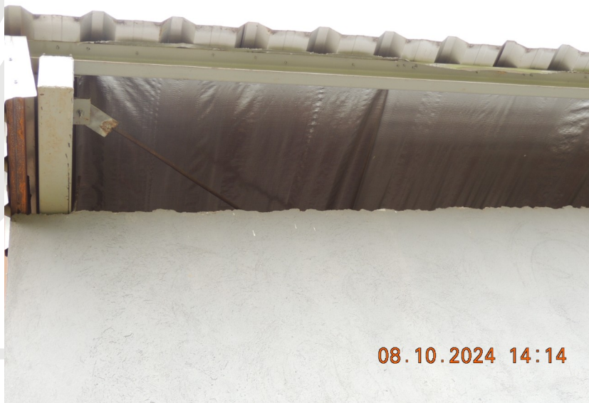
Foto 54- Fechamento do vão entre a parede e o telhado na sala dos técnicos.
