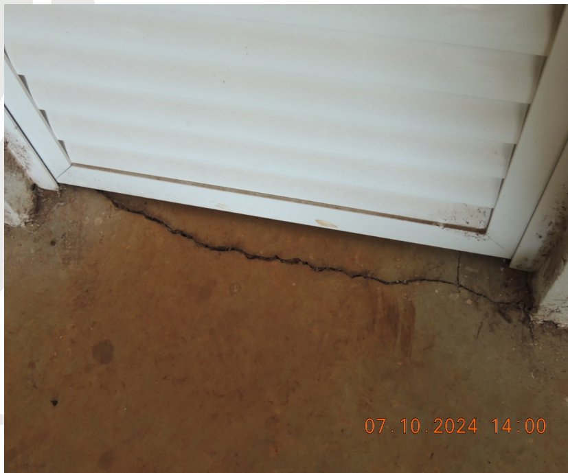
Foto 22 – Conserto de rachadura no piso na entrada das salas.
