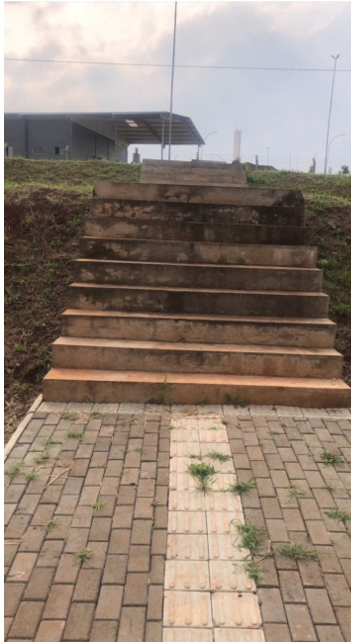
Figura 6 - Inserir guarda corpo na escada
