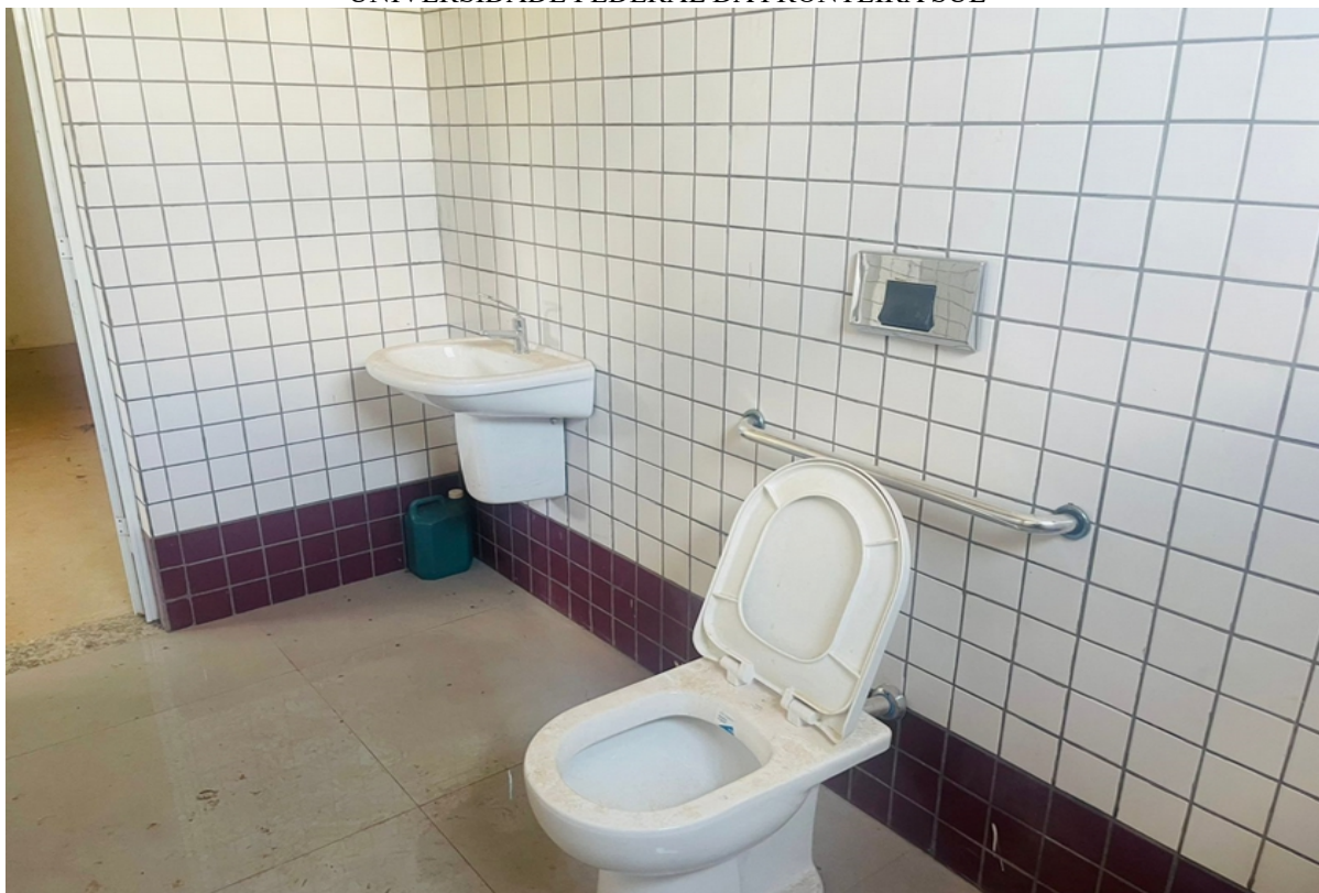
Figura 15 - Finalizar instalação de barras de apoio e espelho
