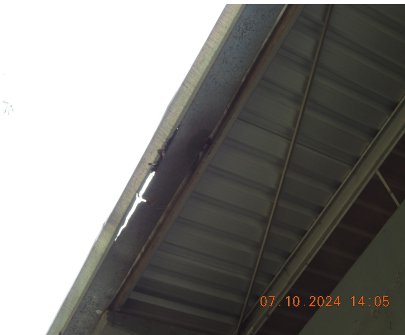
Foto 45- Substituição de calha metálica furada e enferrujada.
