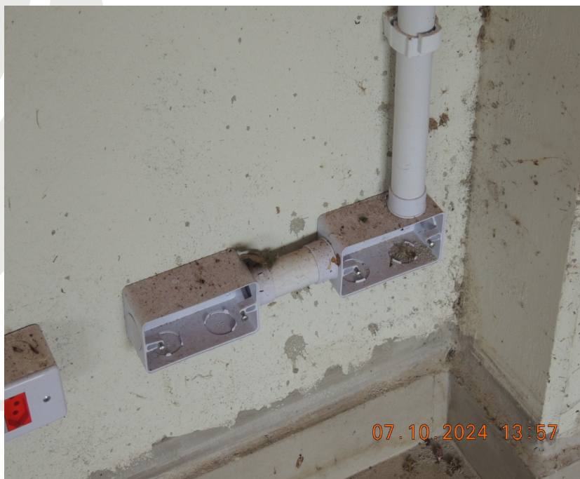
Foto 16 – Finalização da instalação elétrica, passagem de cabos instalação de tomadas e interruptores.
