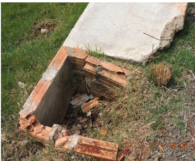
Foto 49- Conserto de caixas de passagem quebradas, refazer tampas de concreto, e reboco.
