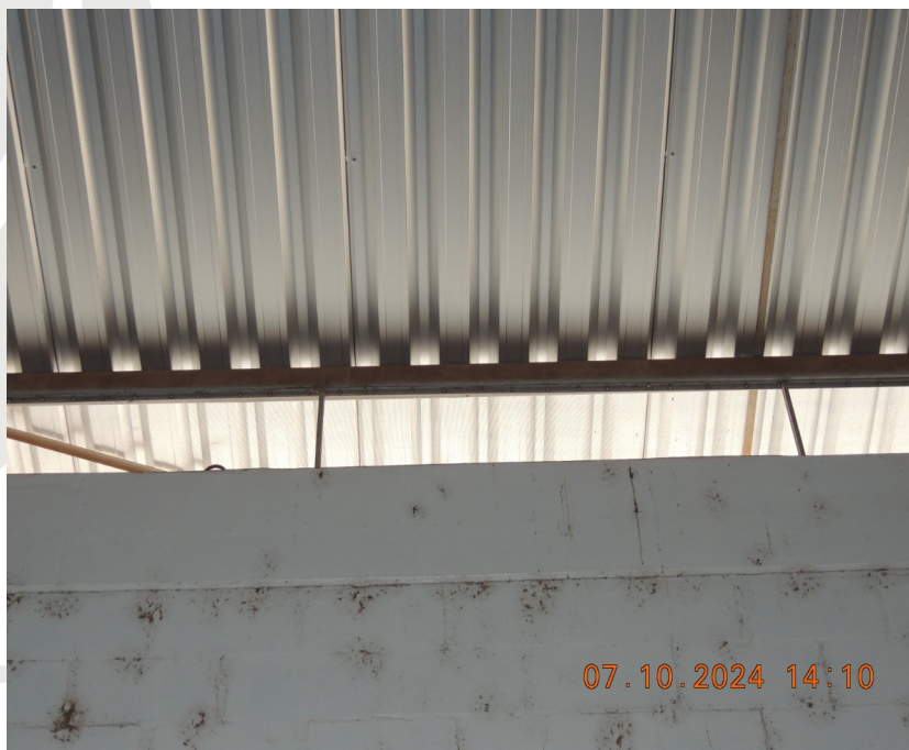
Foto 26 – Fechamento do vão entre o telhado e a parede, com venezianas fixas em alumínio.
