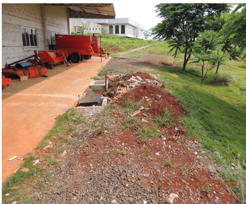
Foto 55-Movimentação de aterro, compactação de base e espalhamento de brita.
