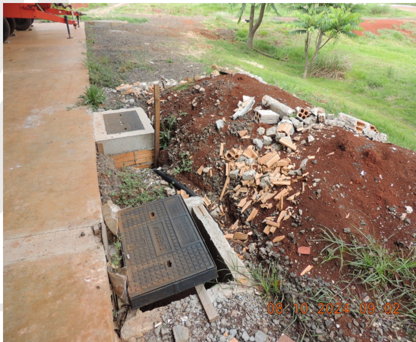
Foto 46- Confecção de colarinhos, e instalação das tampas de ferro fundido nas caixas de inspeção da rede elétrica.
