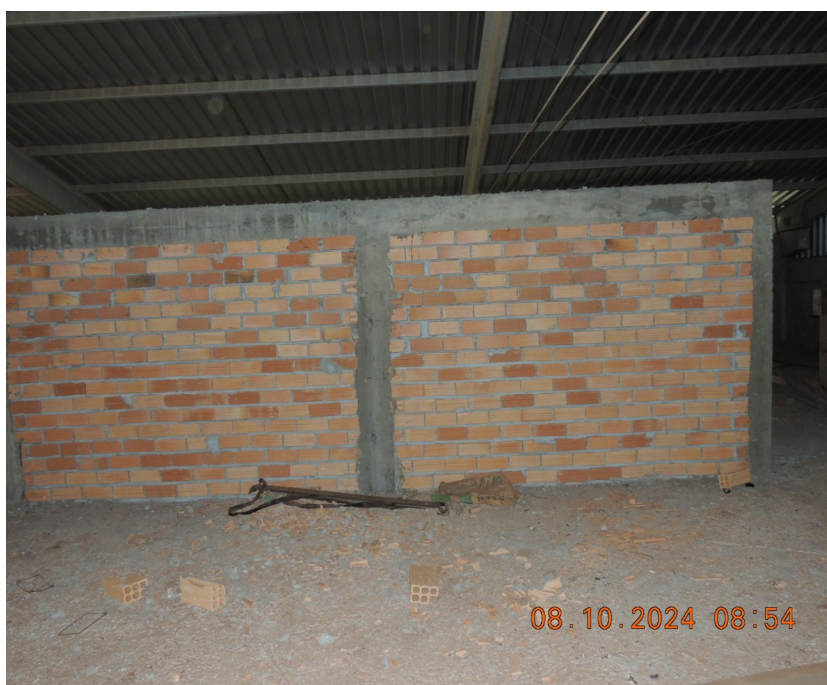
Foto 35- Rebocar a parte interna da parede de proteção do mezanino.
