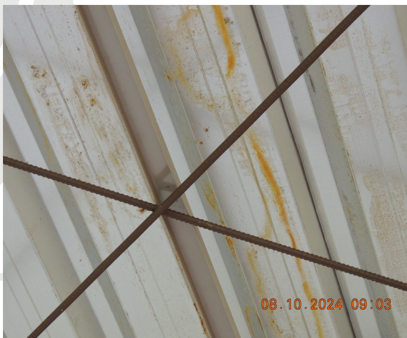
Foto 58- Pintura das barras de contraventamento do telhado da varanda.
