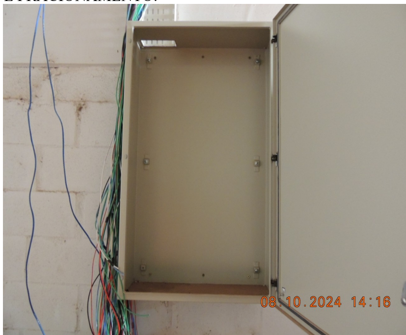
Foto 21 – Finalização da instalação da rede elétrica e montagem do quadro geral de energia.
