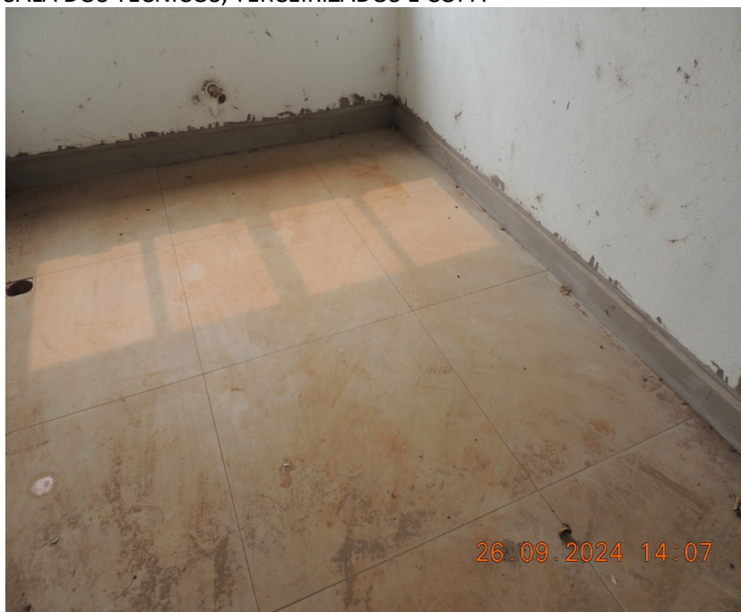
Foto 11 – Limpeza e aplicação de rejunte no piso de porcelanato.
