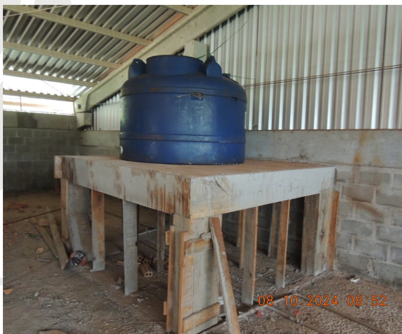
Foto 32 – Finalização da instalação da caixa d'água de abastecimento do galpão, desmontagem de formas e retirada do material.
