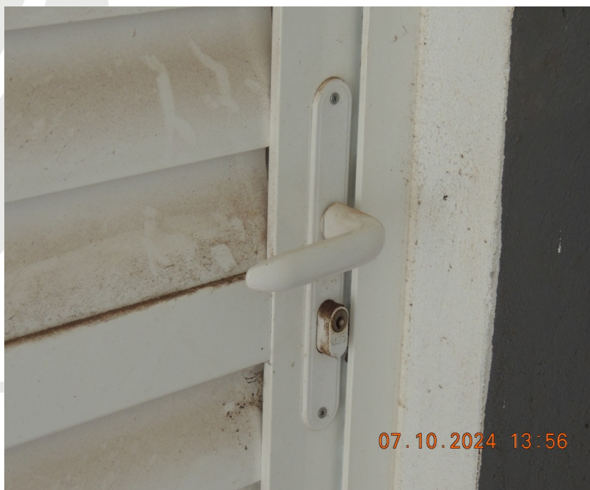
Foto 14 – Substituição dos cilindros das fechaduras.
