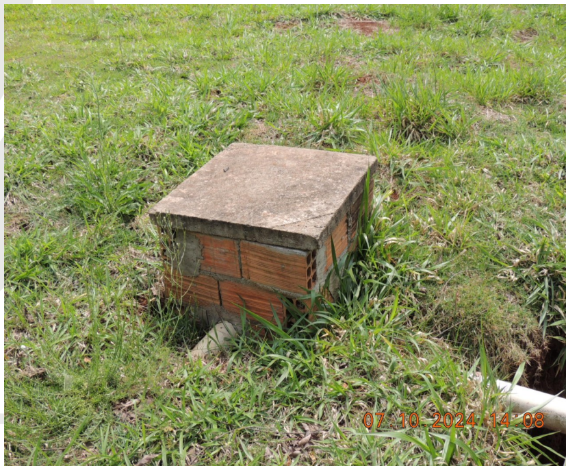
Foto 50- Finalizar o reboco nas caixas de inspeção de esgoto e elétrica.
