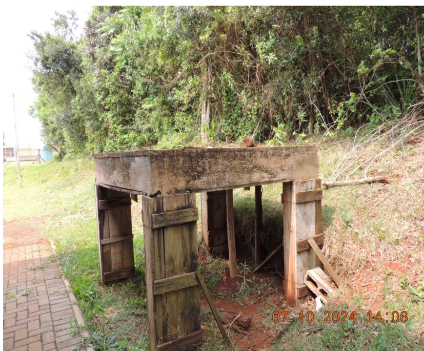
Foto 43- Finalização da base e instalação das caixas d'água de reuso.
