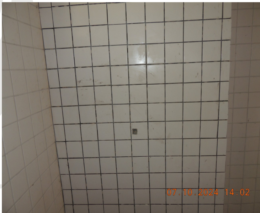
Foto 06 – Aplicar rejunte no porcelanato do piso e nos revestimentos cerâmicos dos banheiros.
