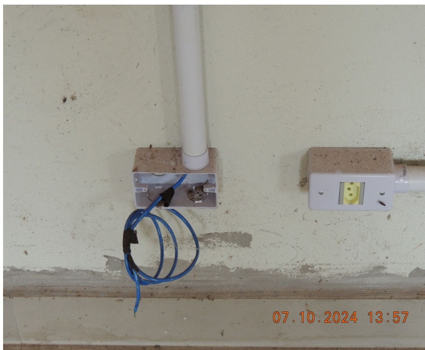
Foto 17 – Finalização da rede lógica passagem de cabos instalação de tomadas.
