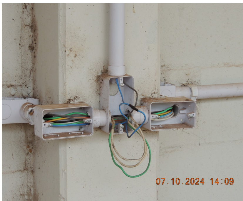
Foto 37- Finalização da rede elétrica instalação de tomadas e interruptores.
