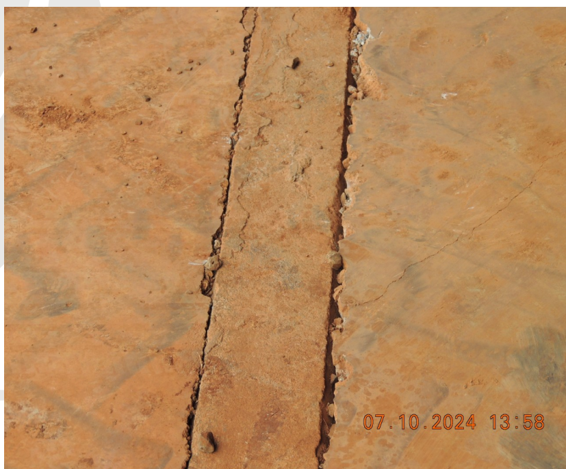
Foto 24 – Conserto de rachaduras nos piso.
