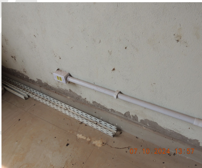
Foto 12 – Realizar a limpeza do rejunte dos rodapés, e pintura das paredes.
