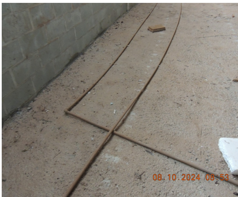
Foto 33- Desmontar e reinstalar a rede hidráulica de abastecimento do galpão.
