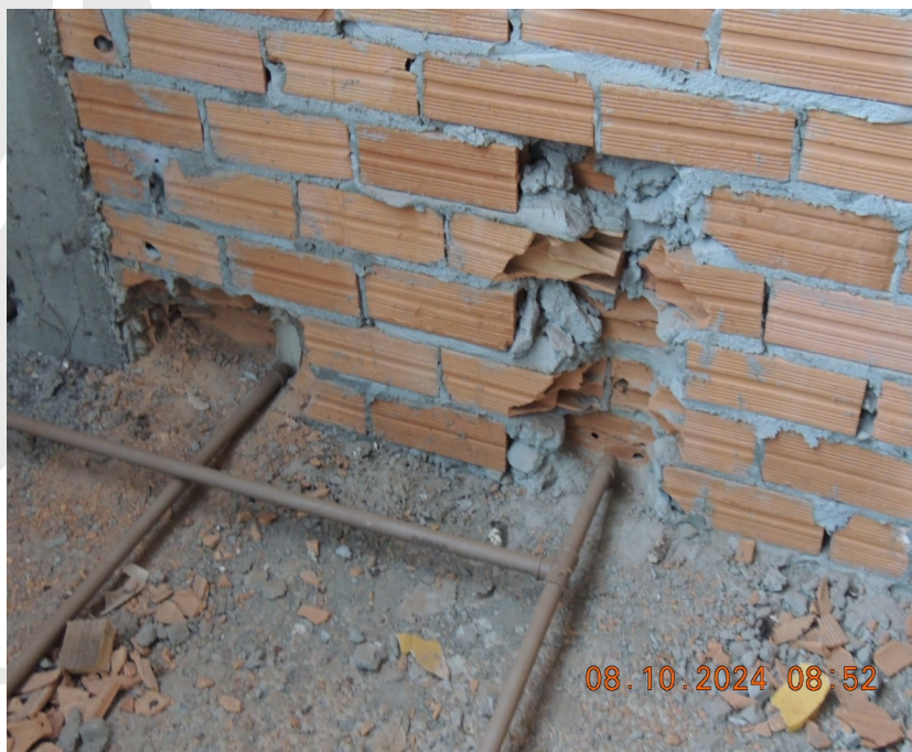
Foto 34- Consertar buracos abertos na alvenaria.
