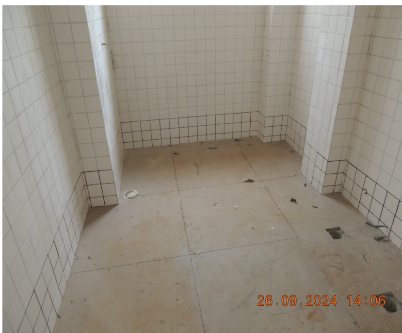
Foto 05 – Aplicar rejunte no porcelanato do piso, e no revestimento cerâmico das paredes dos banheiros masculino e feminino.
