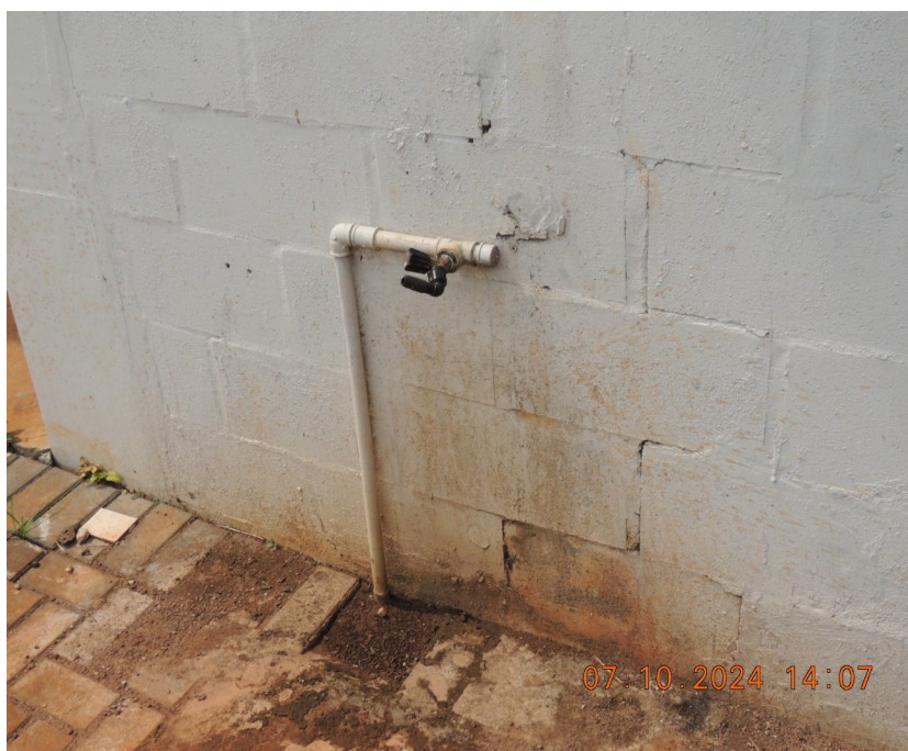
Foto 47- Fornecimento e instalação de hidrômetro na rede de hidráulica de abastecimento do galpão.
