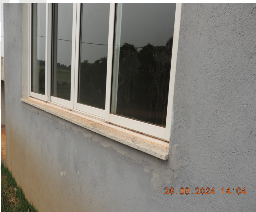
Foto 18 - Refazer o acabamento no peitoril das janelas, pintar as paredes externas das salas dos técnicos, terceirizados e copa.
