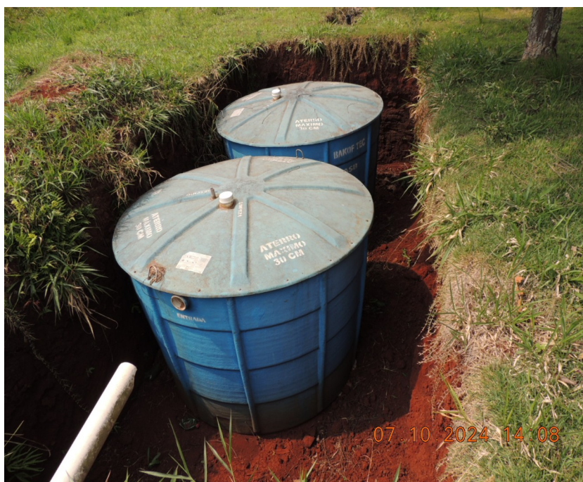
Foto 57- Complementação da instalação do sistema de tratamento de efluentes.
