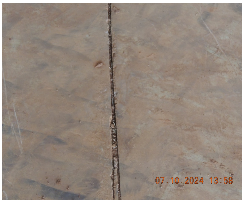
Foto 29 – Tratamento das juntas de dilatação, aplicação de selante.
