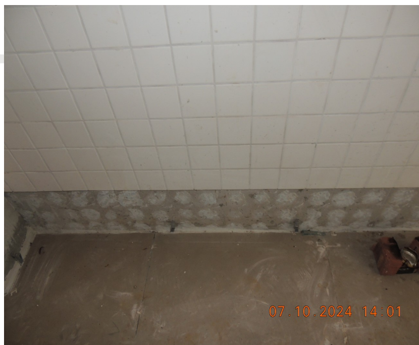
Foto 01- Finalizar a instalação dos azulejos da parede na parte inferior do banheiro feminino.
