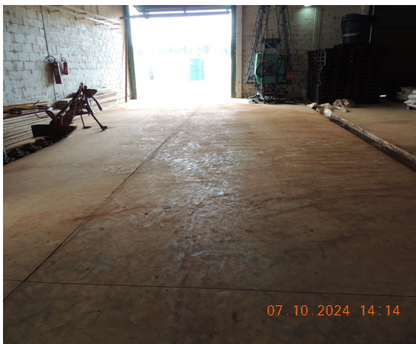
Foto 27 – Limpeza e pintura do piso com tinta epóxi.
