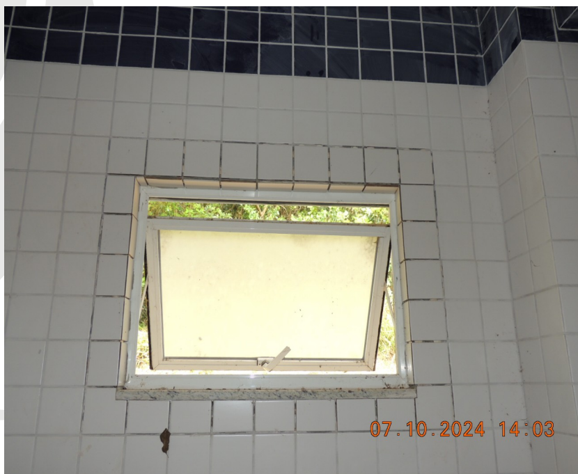
Foto 04 – Finalizar a instalação dos revestimentos cerâmicos nas molduras das janelas, aplicar rejunte.
