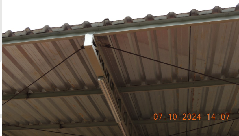
Foto 42 – Instalação de calha metálica no telhado da varanda.
