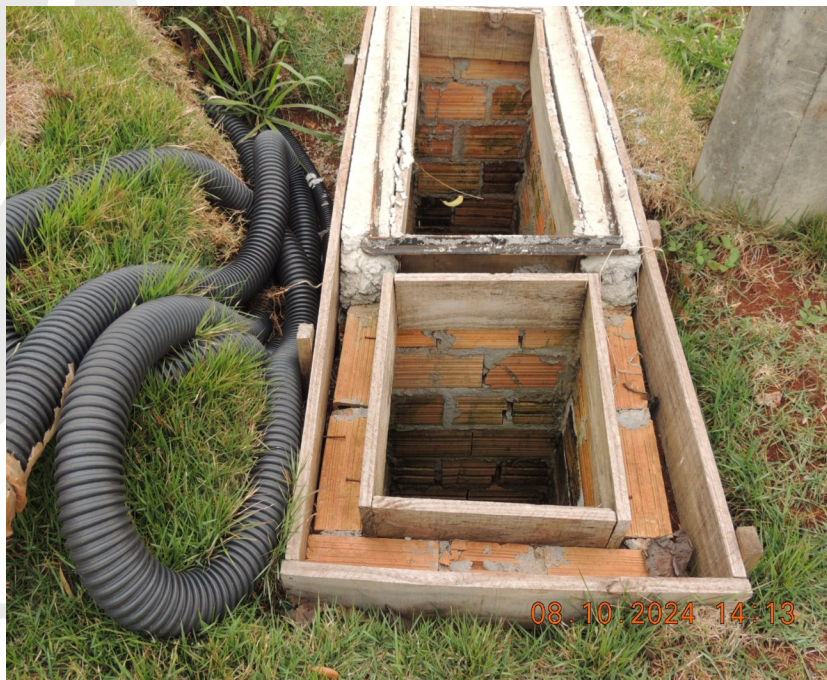
Foto 52- Finalizar a entrada da energia elétrica, de abastecimento do galpão.
