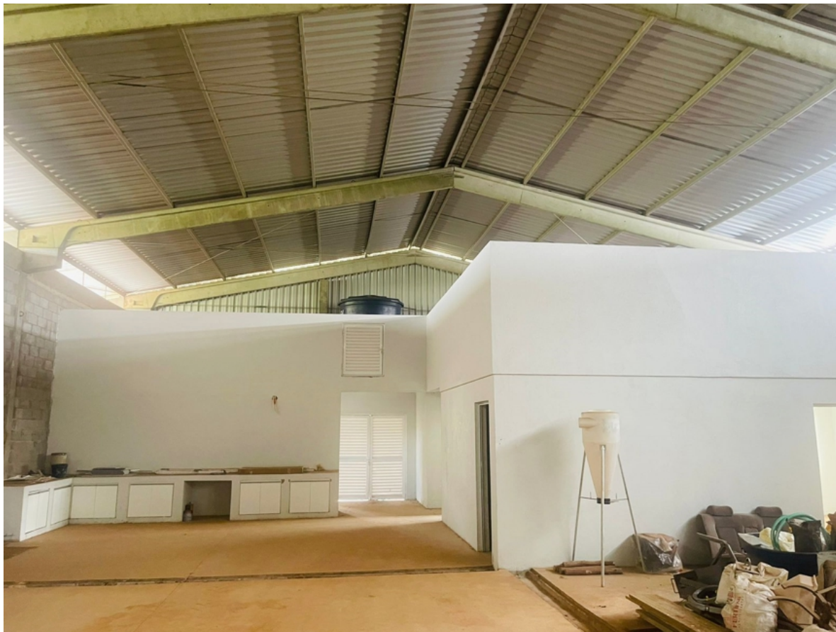
Figura 7 - Repintar as paredes e acabamento de concreto polido no piso
