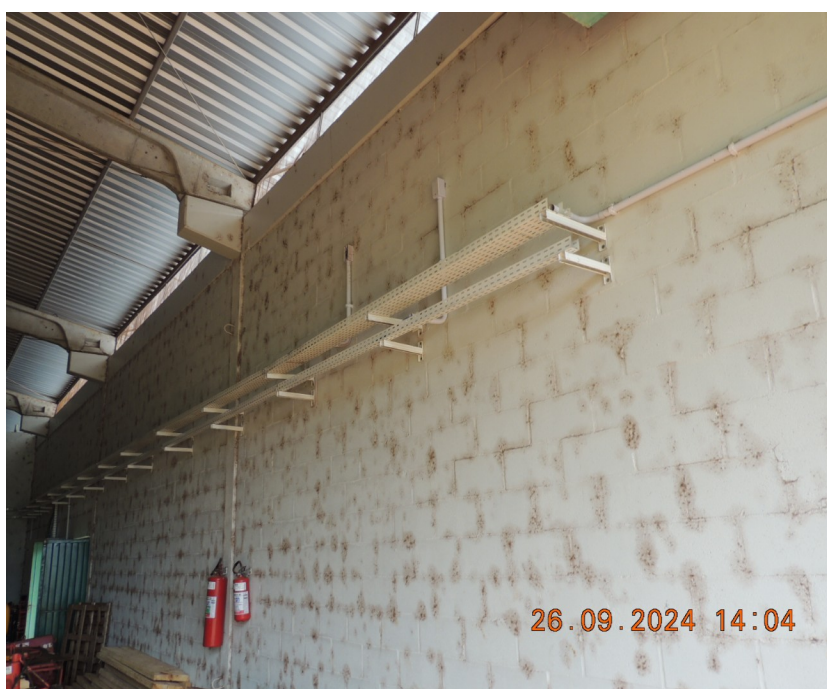
Foto 23 – Finalização da instalação da rede elétrica, complementação das eletrocalhas passagem de cabos.
