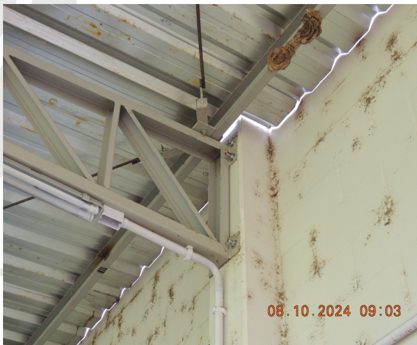
Foto 38- Instalação de reforço na estrutura metálica da cobertura da varanda.
